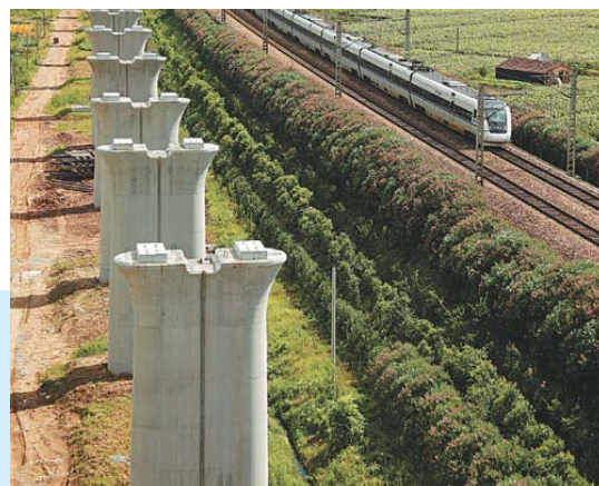
高墩施工注重生态保护
