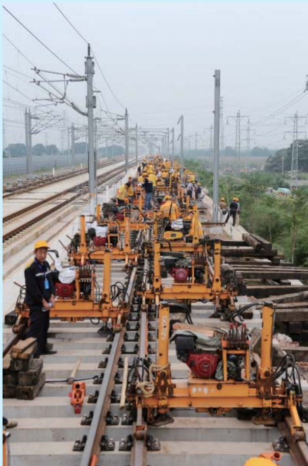
全国首例高速铁路道岔施工
