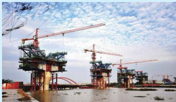
沪昆铁路客运专线浙江段施工
