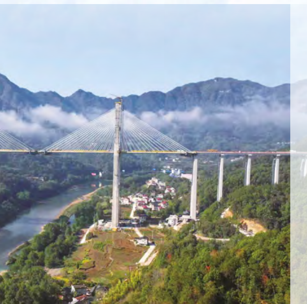
• 爐慈高速長潭河淩水特大橋
