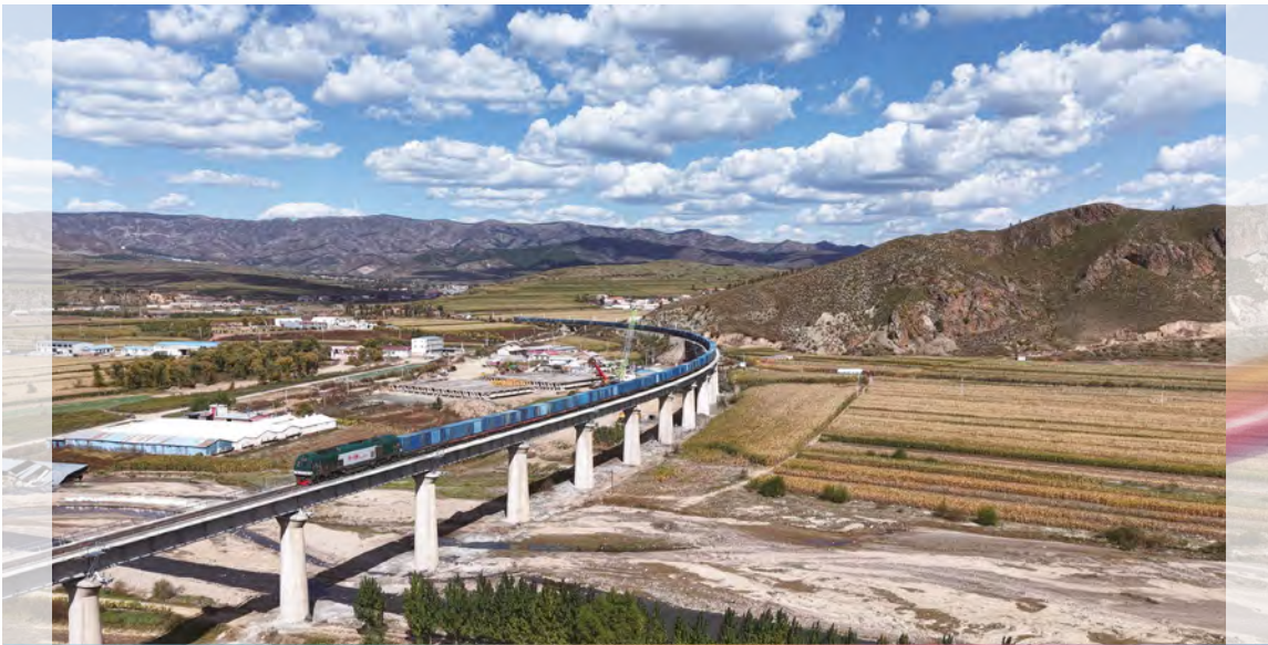
• 京通鐵路換梁改造工程
