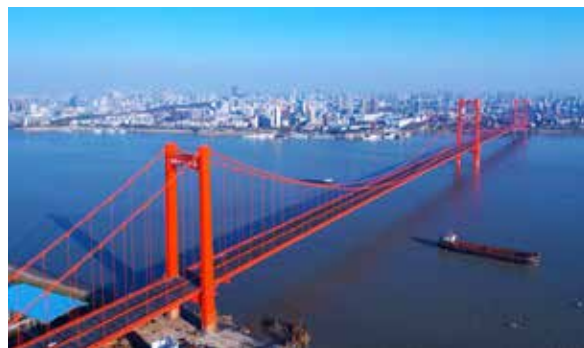
武汉鹦鹉洲长江大桥
