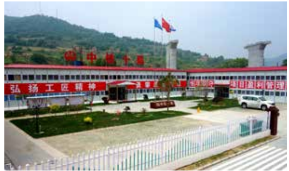
中铁十局蒙华铁路梁场办公生活区
