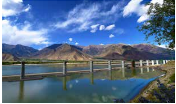
拉林铁路绿色施工
