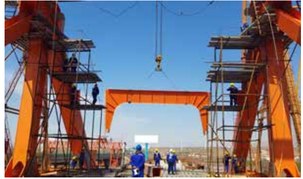
官厅水库特大桥钢梁拼装
