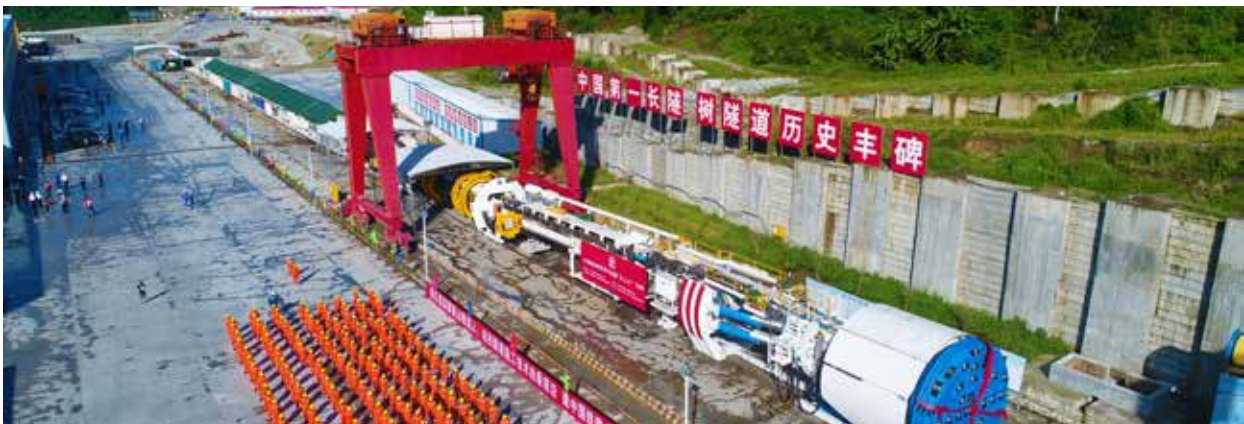
中铁隧道局承建的大瑞铁路高黎贡山隧道“彩云号”始发
