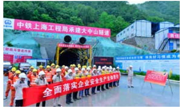
中铁上海工程局蒙华铁路大中山隧道安全宣誓
