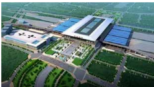
合肥枢纽南环线合肥南站工程
